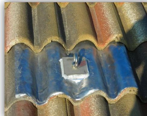
Gli ancoraggi conformi alle norme UNI EN 795-classe A sono elementi strutturali isolati, posti su superfici o tetti o in corrispondenza di una parete, atti ad assicurare gli operatori durante l'attività di manutenzione.
