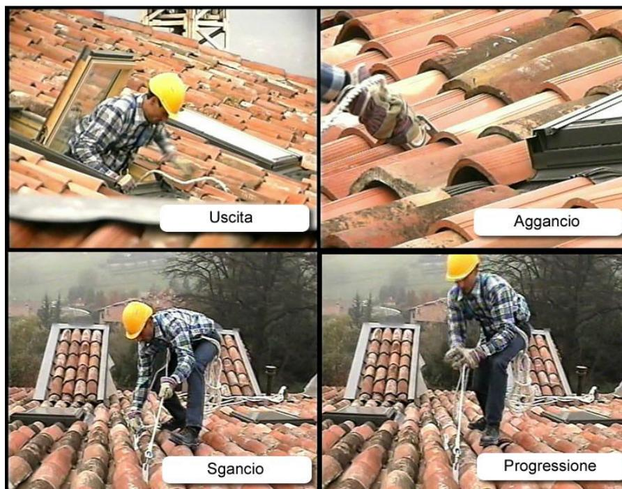
Il dispositivo che consente all'operatore di spostarsi in copertura, assicurandosi a questo tipo di ancoraggio, è costituito da doppio cordino conforme alla norma UNI EN 354 con dissipatore di energia UNI EN 355 e da una imbracatura per il corpo a norma UNI EN 361.
