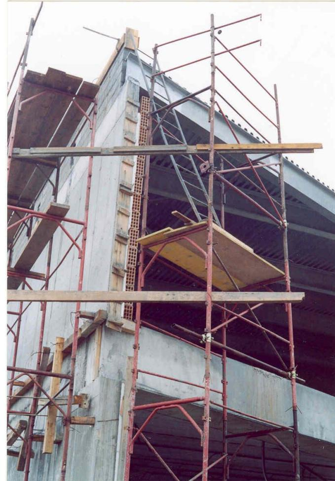
L'accesso ai piani del ponteggio dovrebbe essere realizzato con il montaggio di una torre scala affiancata, oppure direttamente dall'opera servita.
